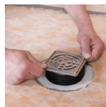
ad 9. Mřížka z ušlechtilé oceli s podnoží se v průběhu pokládky osadí do správné výšky
