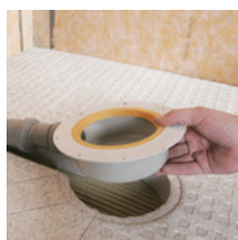
ad 3. Osadí se odtokové těleso
